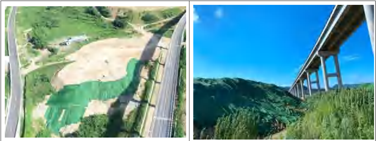
坝前 1#、2#表土堆场临时苫盖防护
