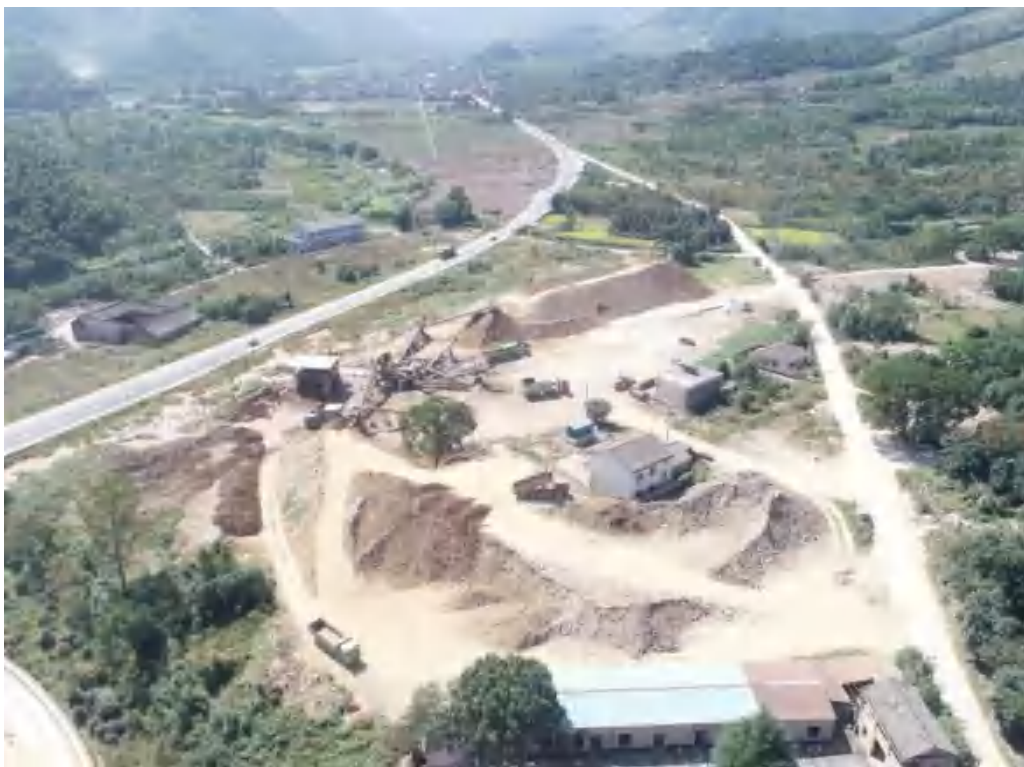
库尾砂石料筛分加工站施工面貌
