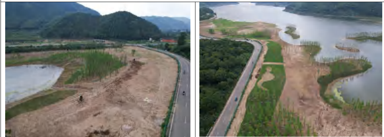
库尾消落带覆土
