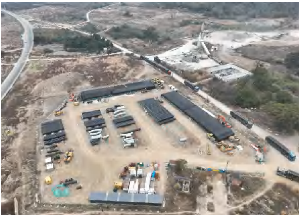
库尾砂石料筛分加工站现状面貌（已移交至甬绍干线东段天然气管道工程作为施工临设区使用）
