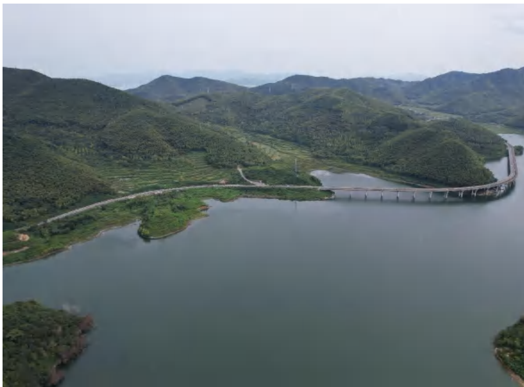
库区公路（A 线）现状面貌
