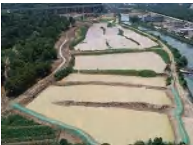
采砂场新开挖沉淀池
