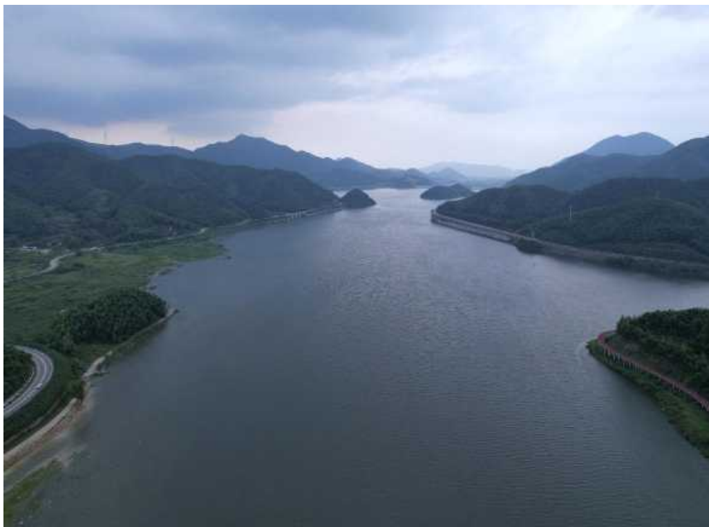
水库淹没区现状面貌
