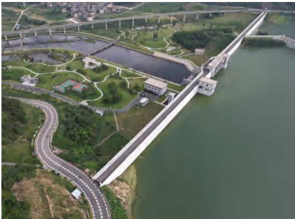
大坝主体现状面貌
