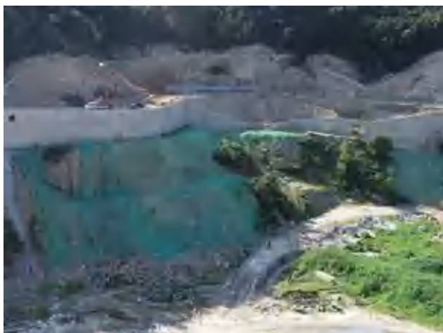
裸露边坡苫盖防护
