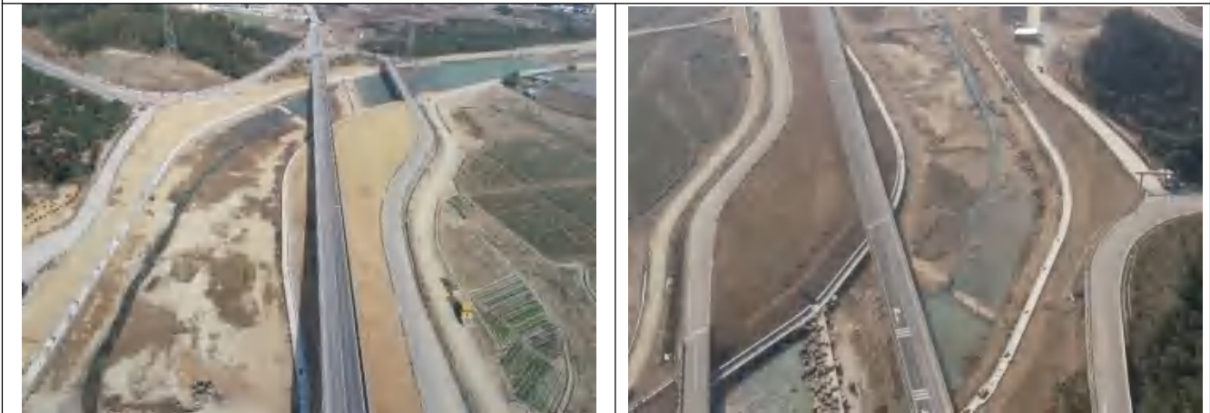
河道工程绿化覆土
