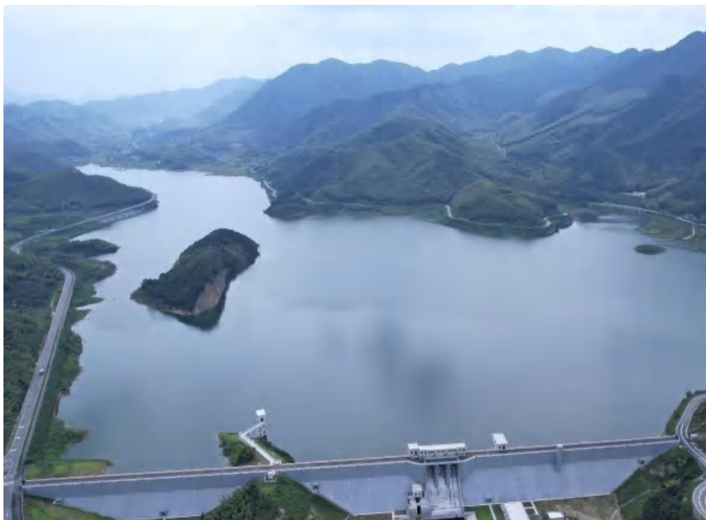
水库淹没区现状面貌
