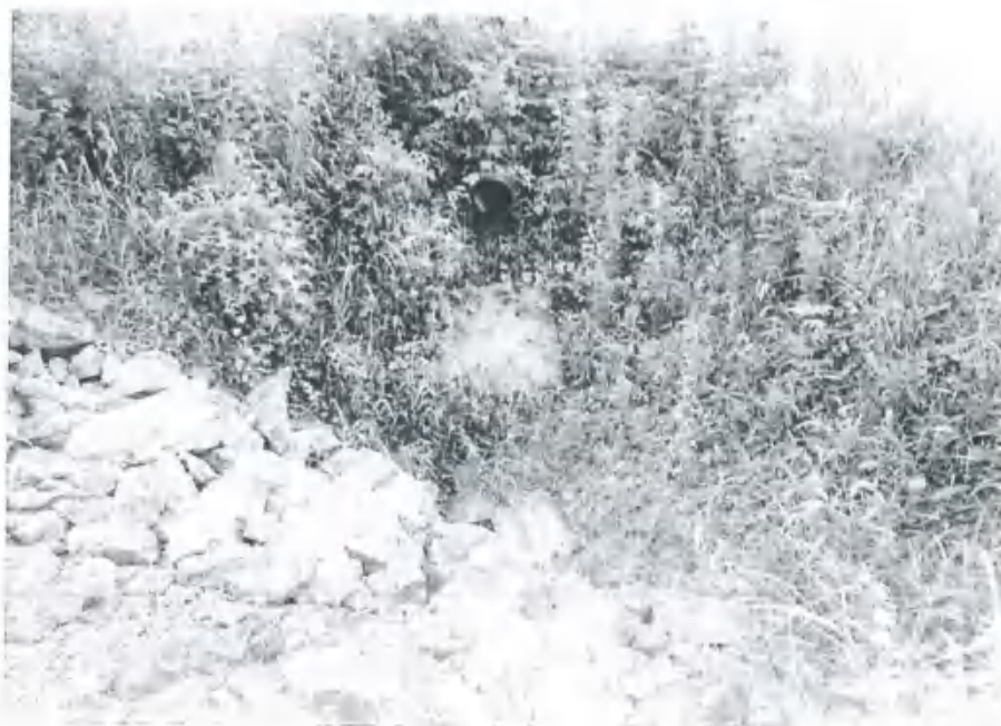
出水管封堵前
