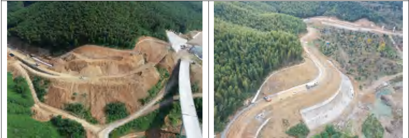
库区公路开挖填筑边坡覆土
