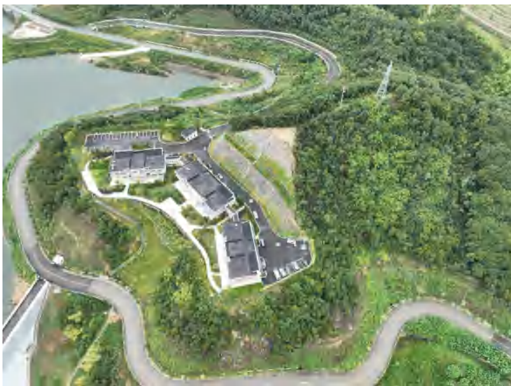
水库管理房及进场道路现状面貌
