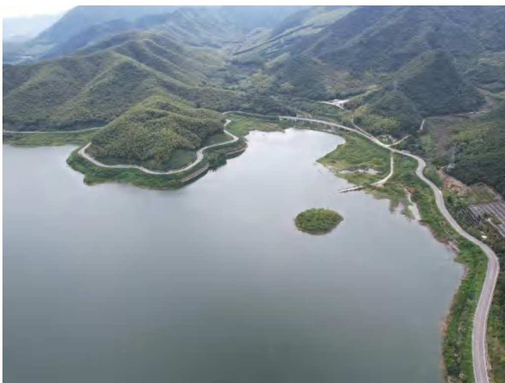
库区公路（B 线）现状面貌
