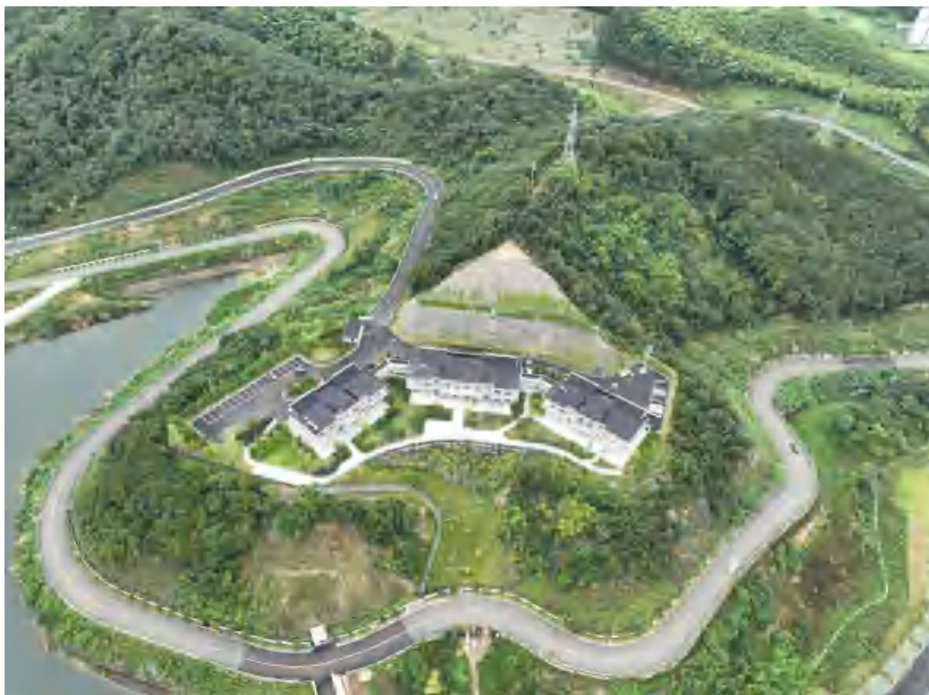
水库管理房及进场道路现状面貌
