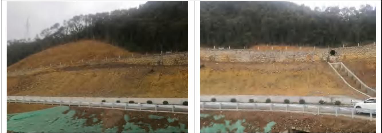
库区公路开挖填筑边坡覆土
