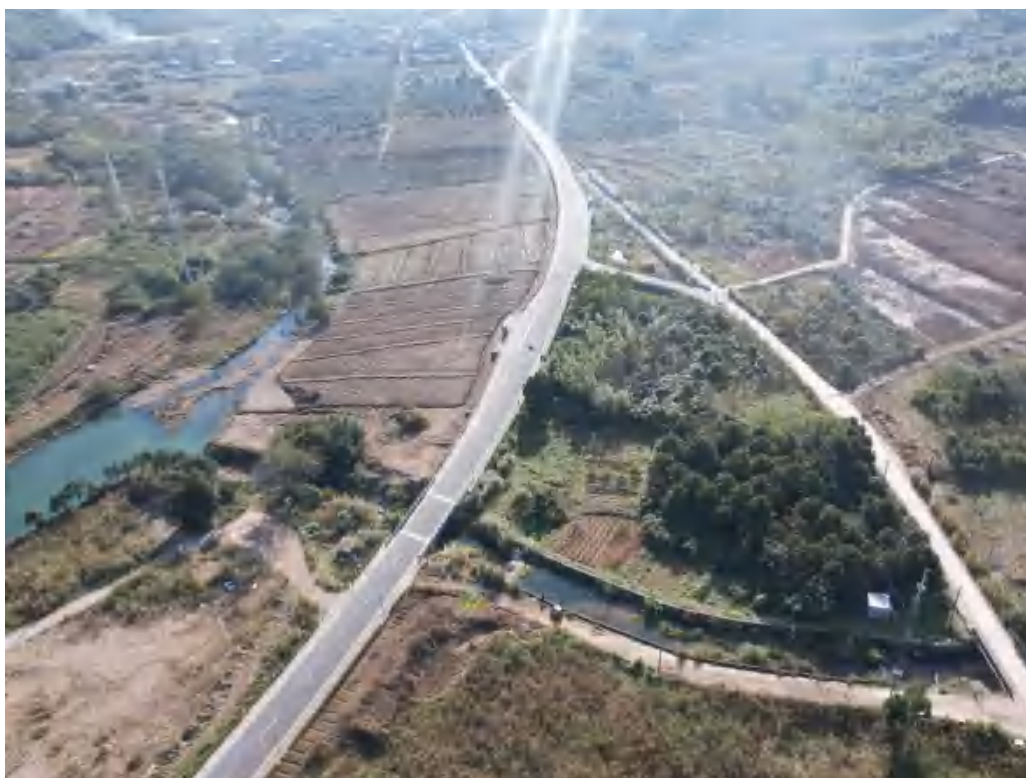
库区公路（A 线）现状面貌
