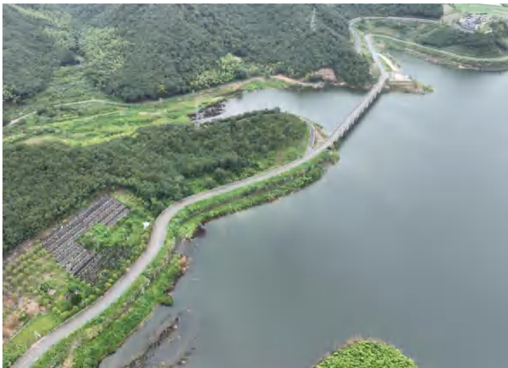
库区公路（B 线）现状面貌
