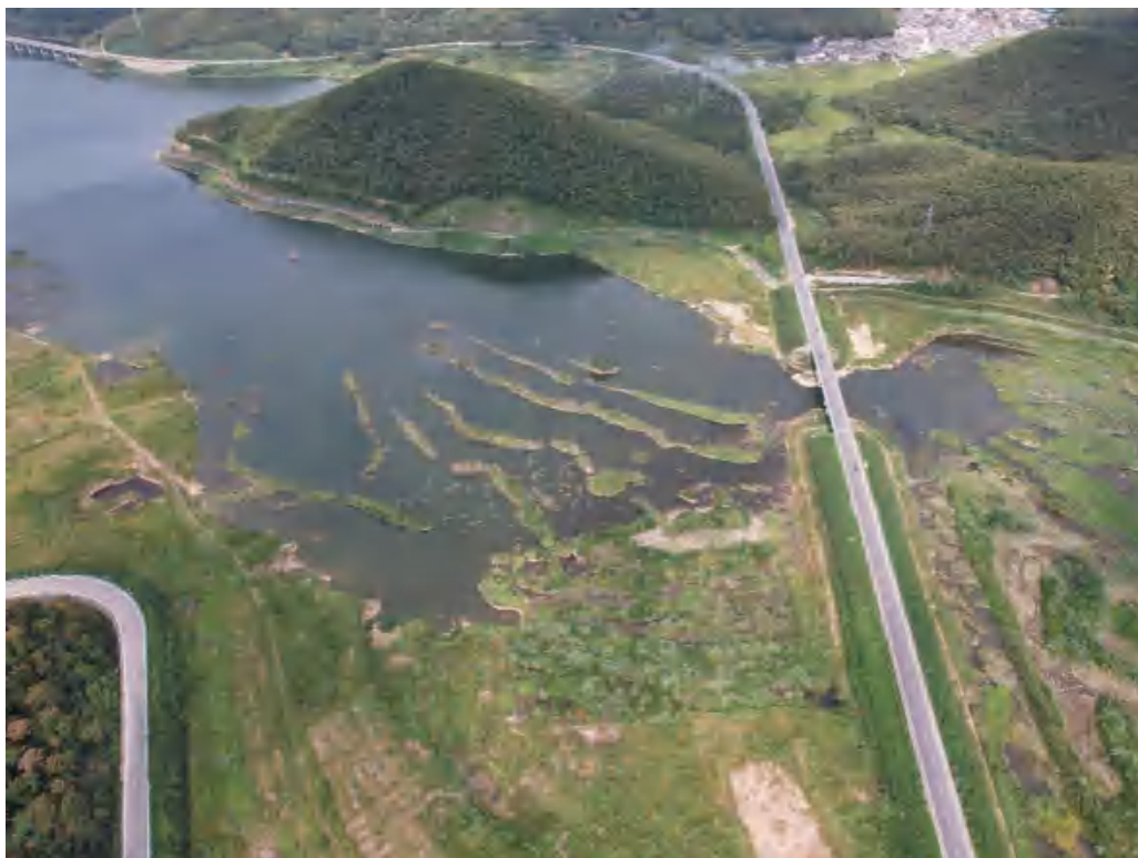
库区公路（A 线）现状面貌
