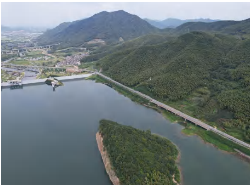
库区公路（A 线）现状面貌
