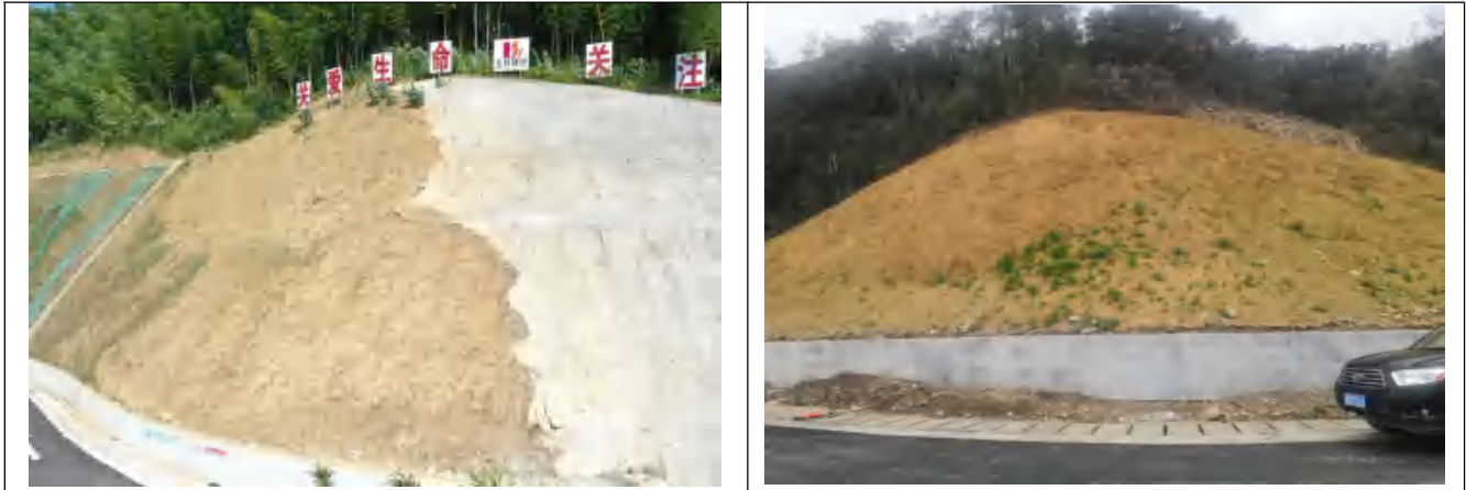
库区公路边坡绿化喷播覆土
