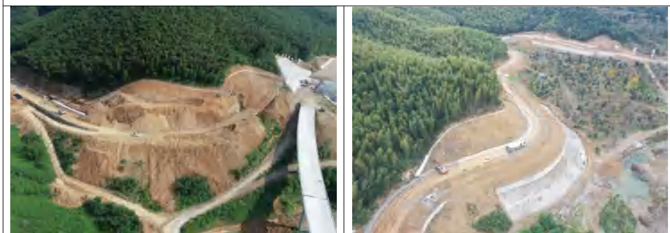
库区公路开挖填筑边坡覆土
