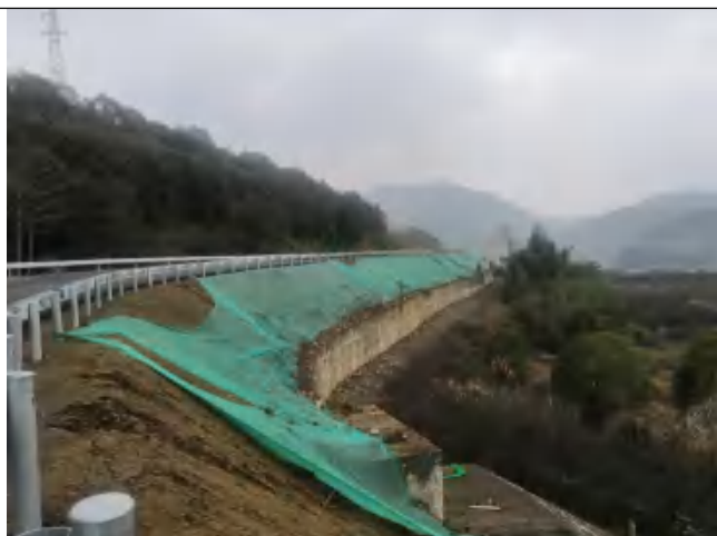
道路填筑边坡临时苫盖防护
