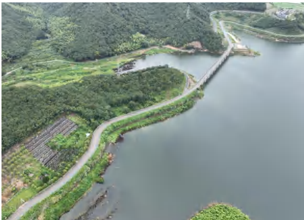
库区公路（B 线）现状面貌
