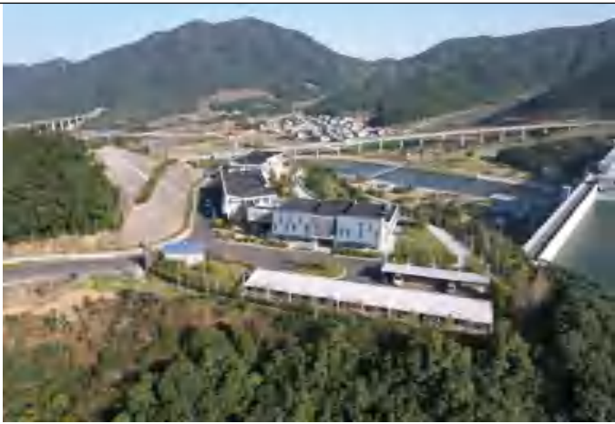
水库管理房及进场道路现状面貌
