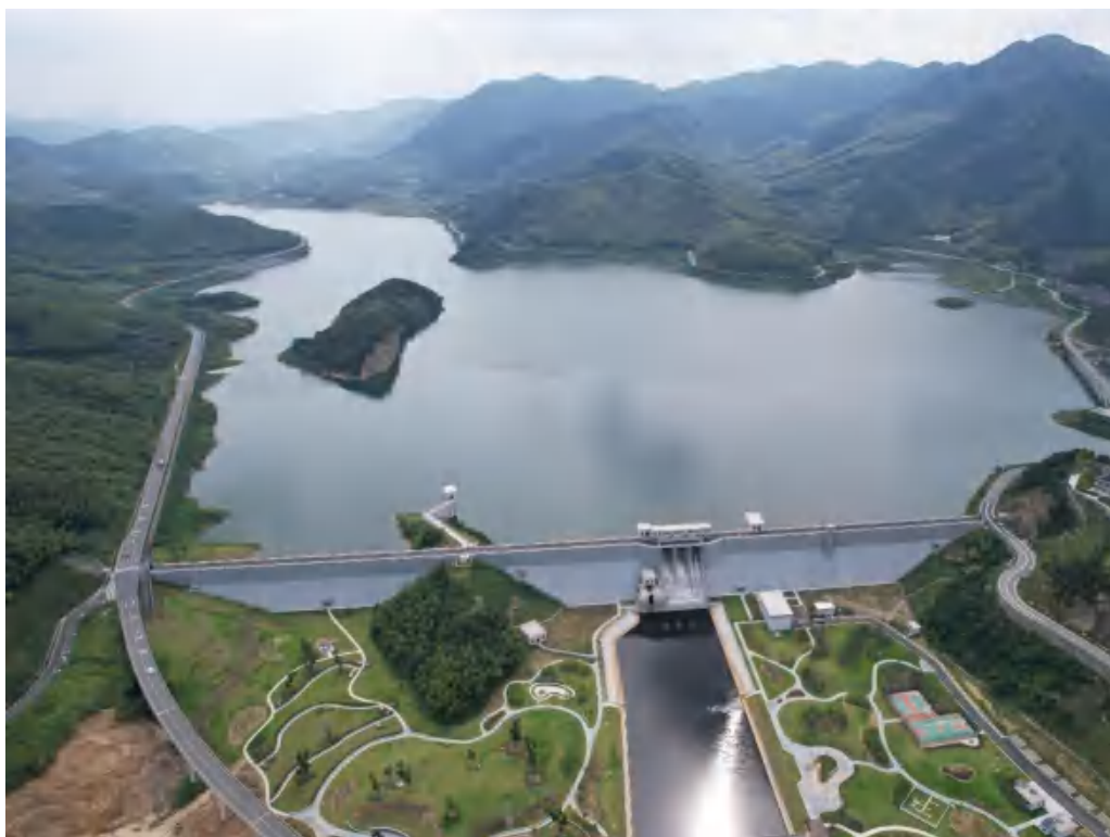
大坝主体及库区现状面貌
