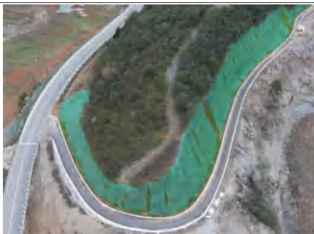
道路开挖边坡苫盖防护
