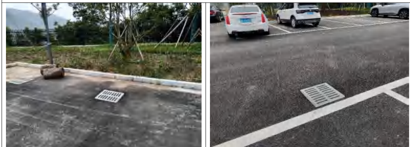
水库管理区排水工程
