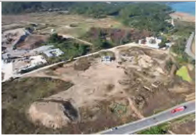
库尾砂石料筛分加工站现状面貌
