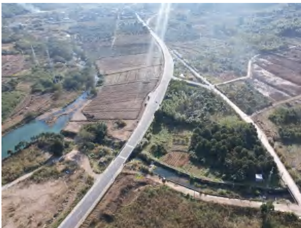
库区公路（A 线）现状面貌
