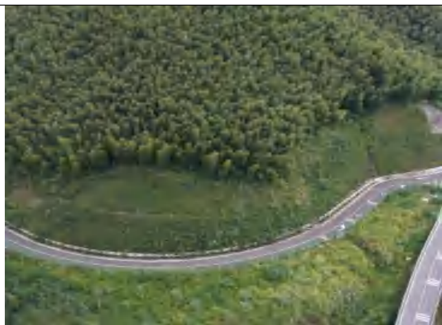
挂双网喷播有机基材绿化
