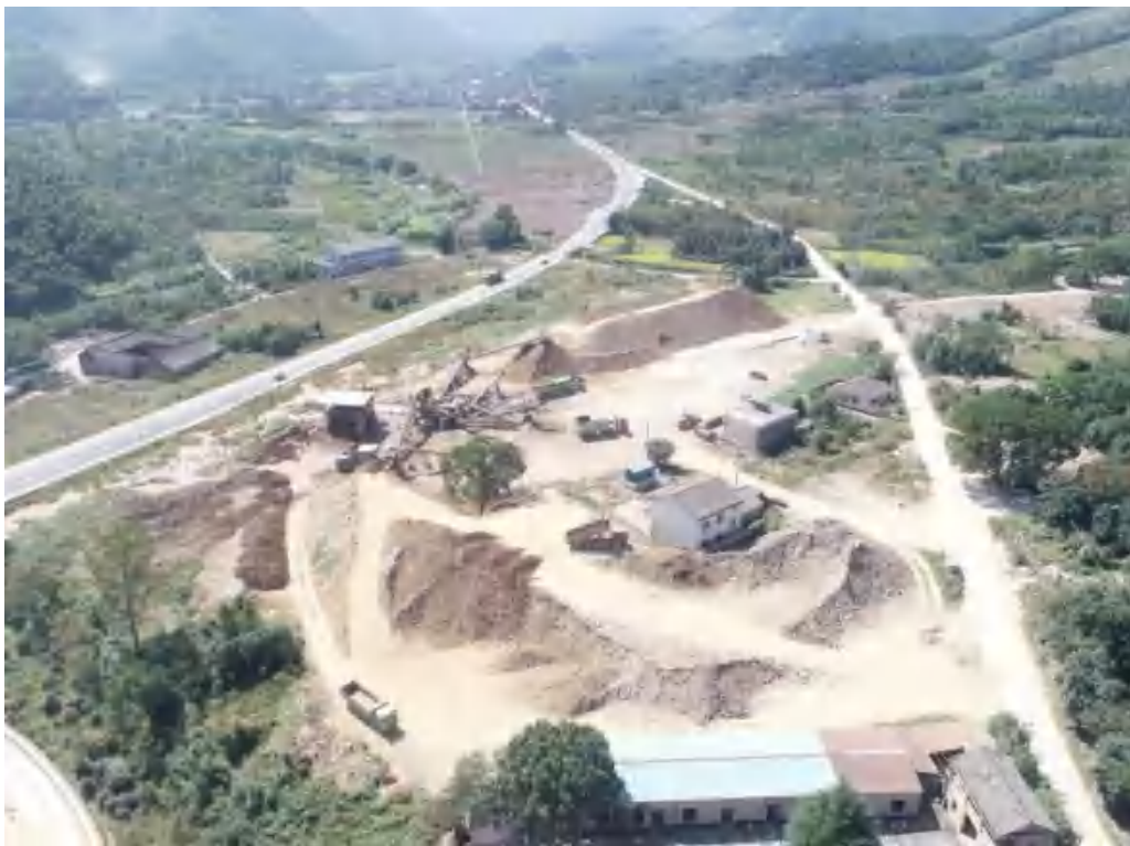
库尾砂石料筛分加工站施工面貌
