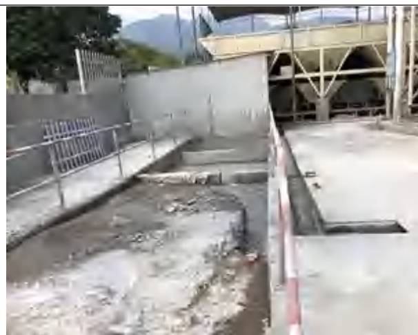
拌合站沉淀池
