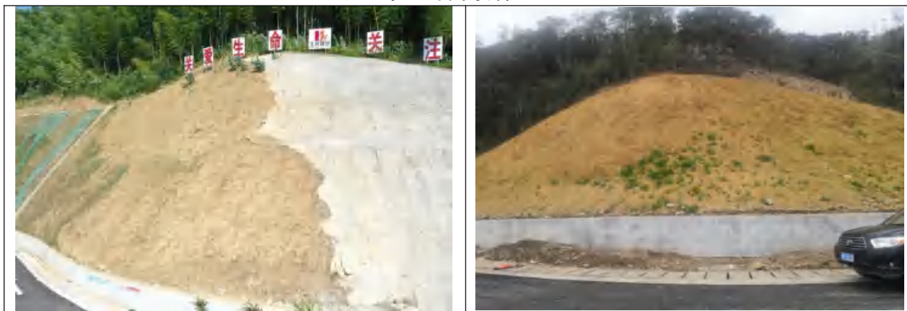
库区公路边坡绿化喷播覆土
