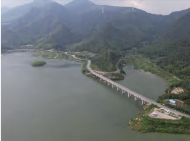
库区公路区现状
