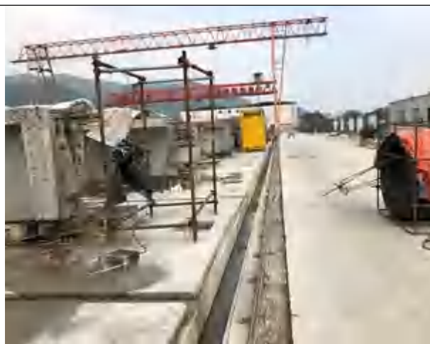
拌合站排水沟
