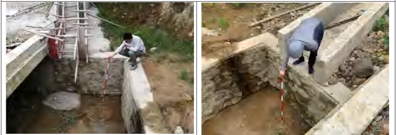
集沙池法获取水土流失基础数据（排水出口沉沙池）
