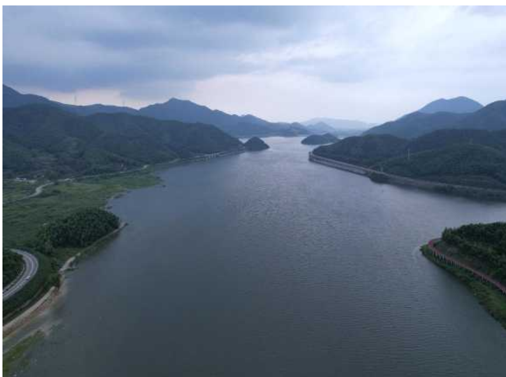
水库淹没区现状面貌
