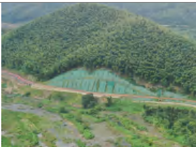
道路开挖边坡临时苫盖防护
