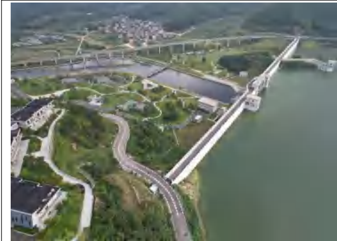
水库工程区现状
