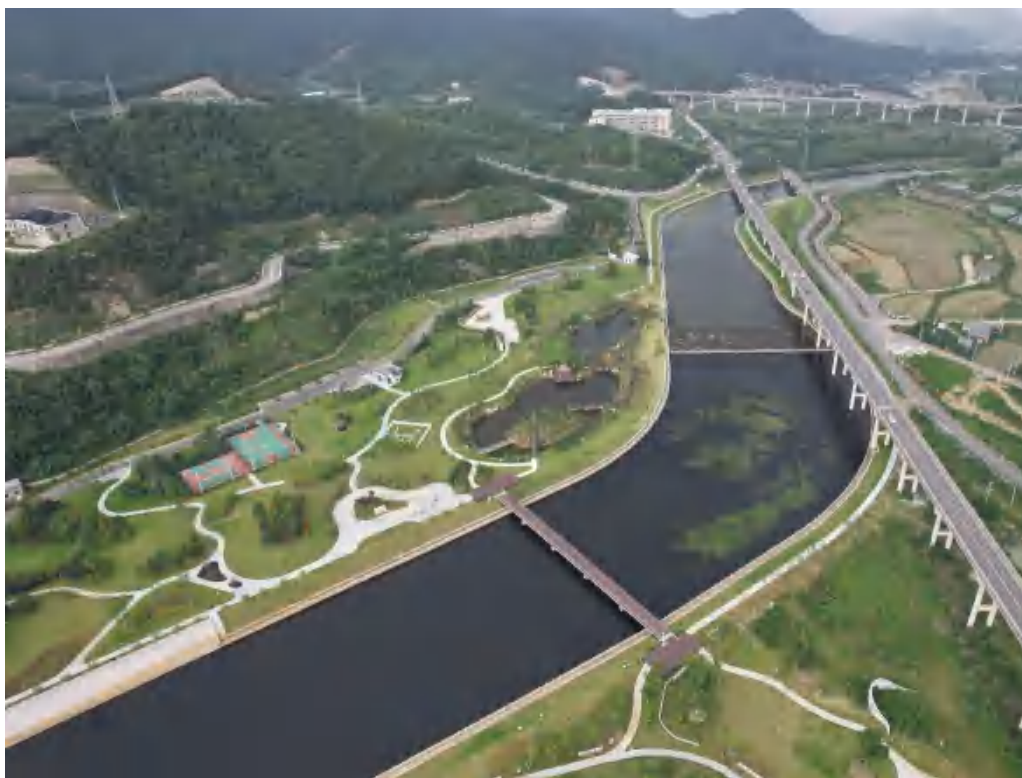
下游河道及两侧河岸现状面貌
