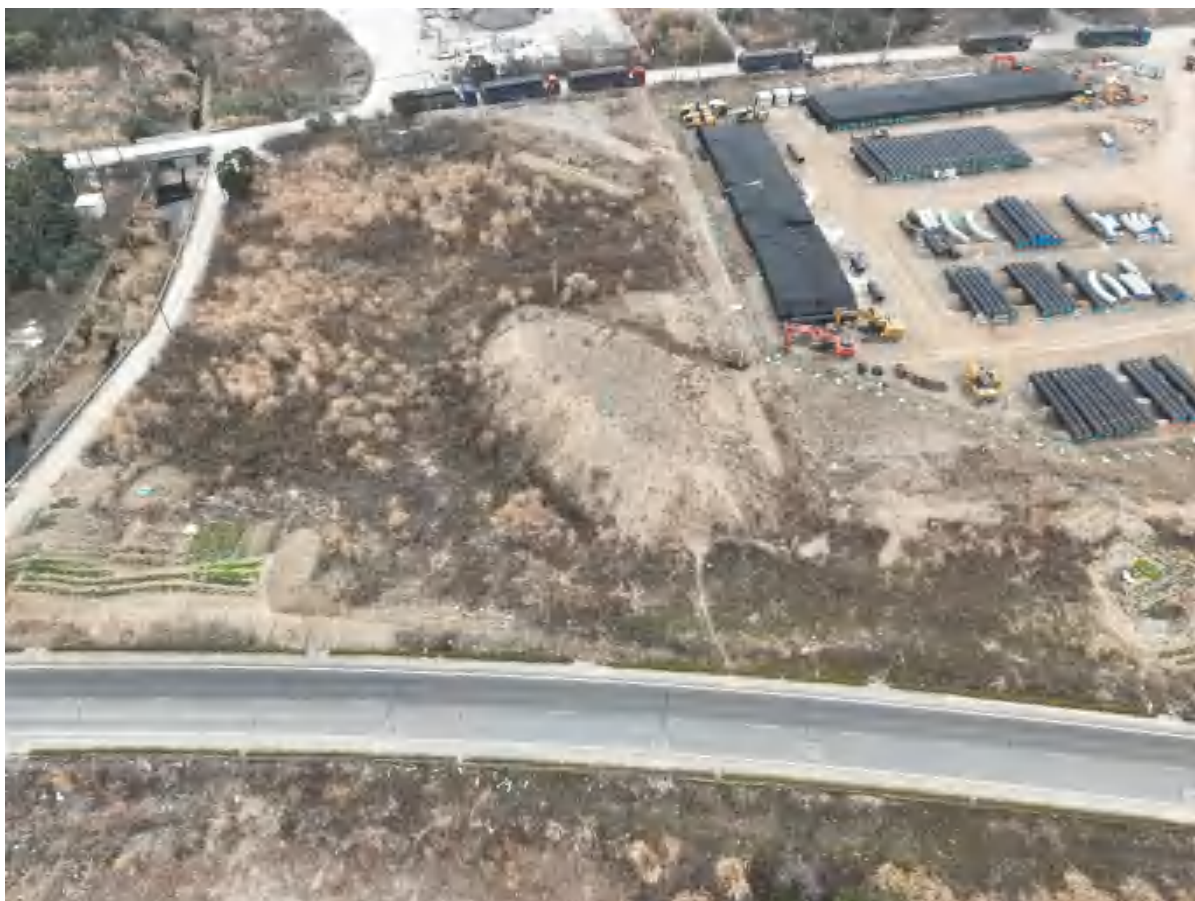
库尾砂砾石料（用作防汛物资临时堆置）
