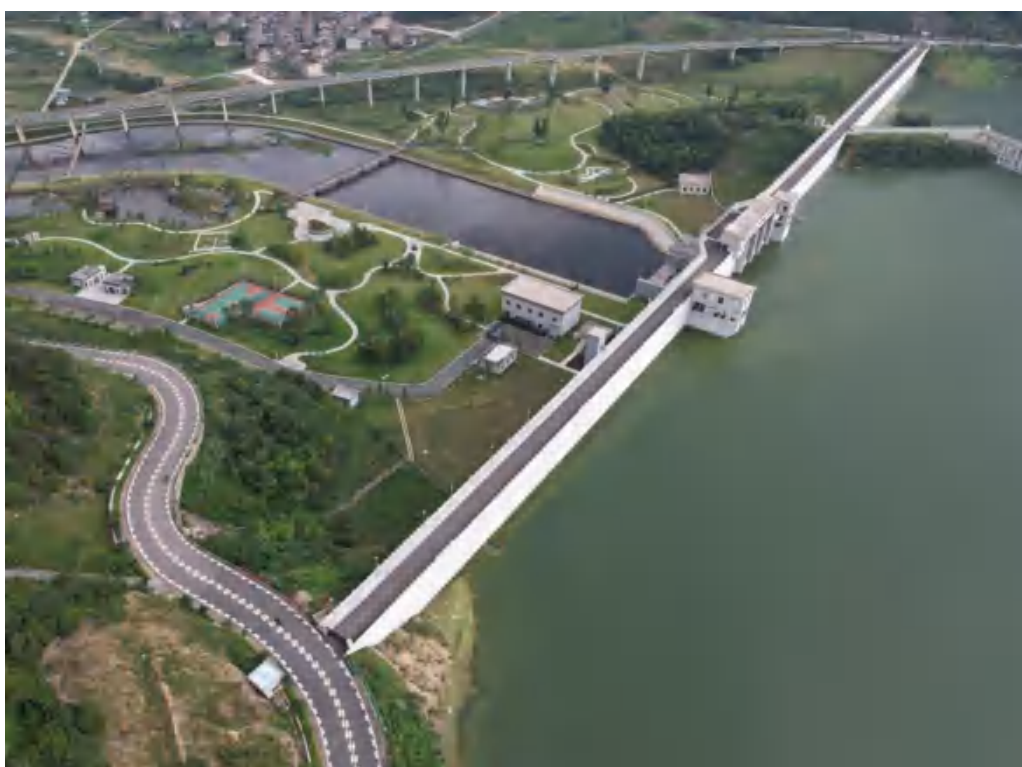
大坝主体现状面貌
