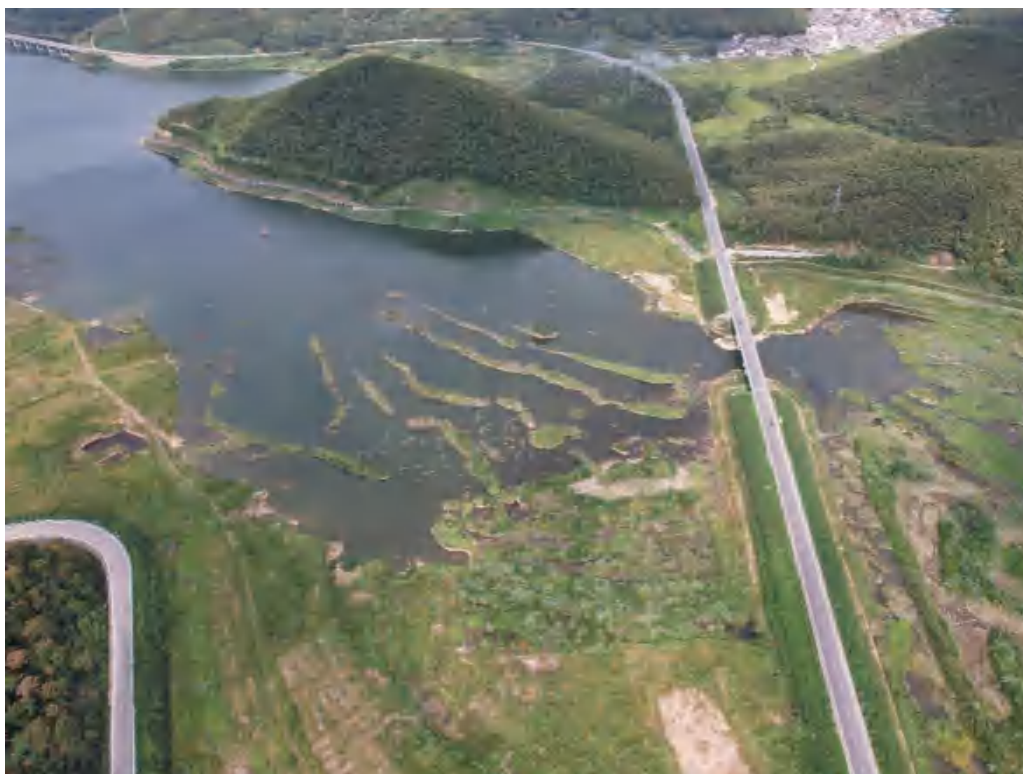
库区公路（A 线）现状面貌
