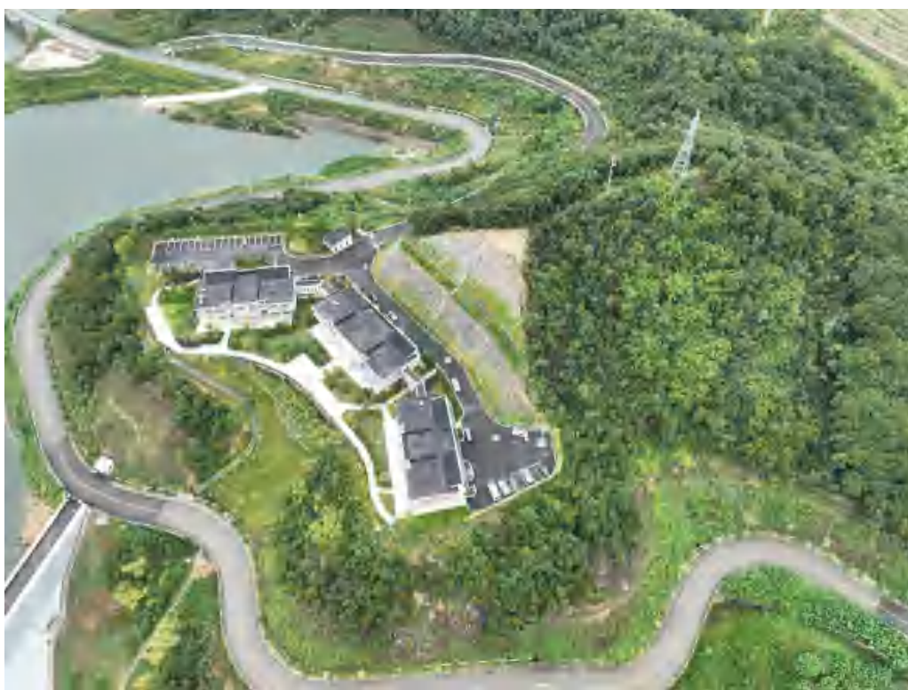
水库管理房及进场道路现状面貌
