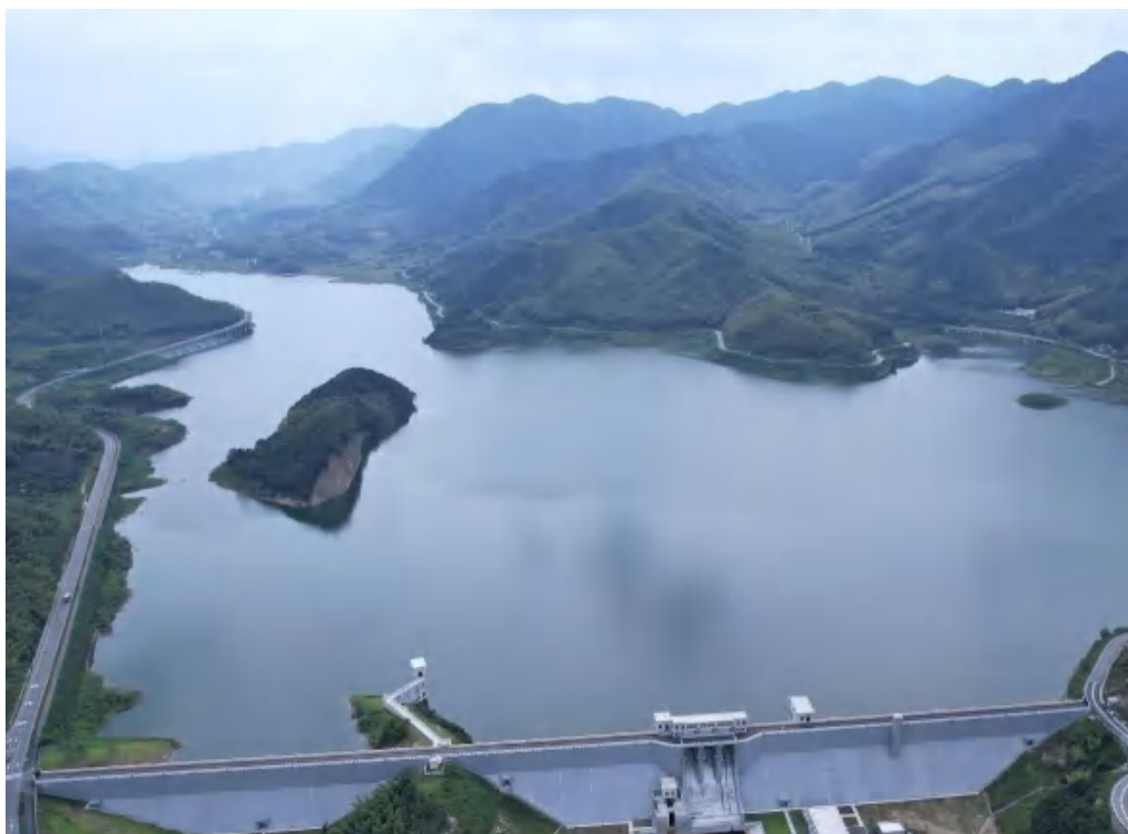
水库淹没区现状面貌
