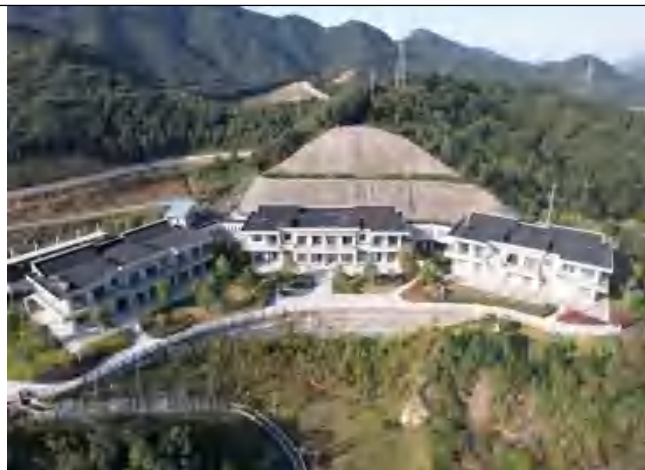
水库管理房及进场道路现状面貌
