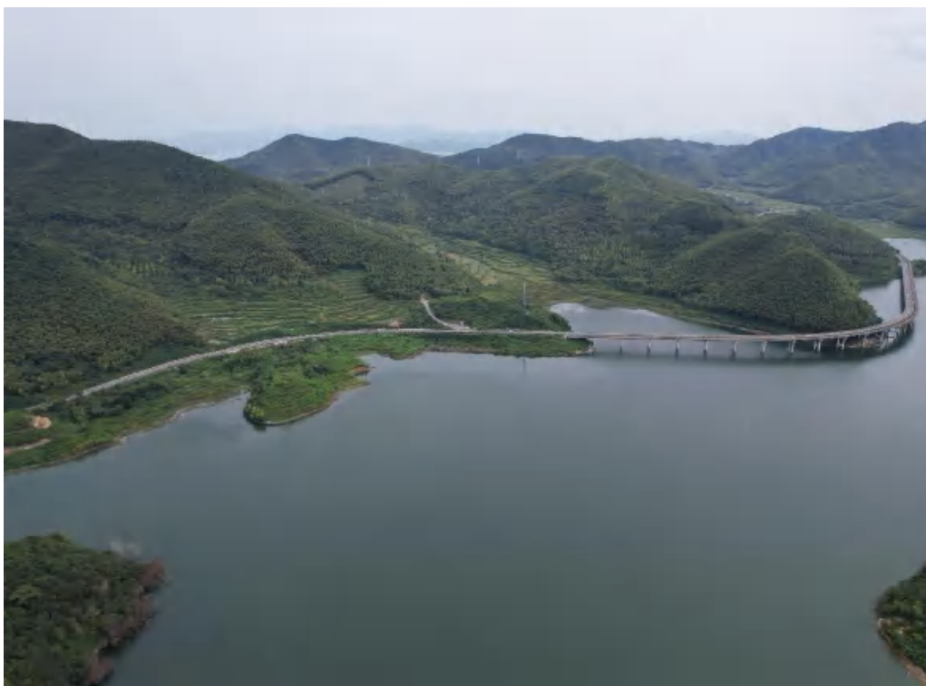
库区公路（A 线）现状面貌
