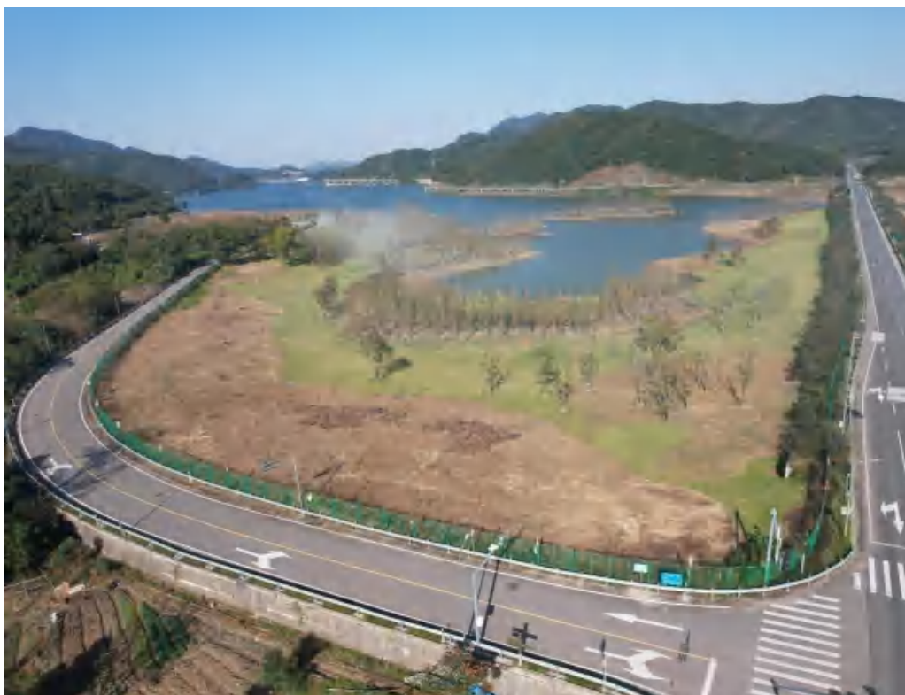
库尾消落带现状面貌
