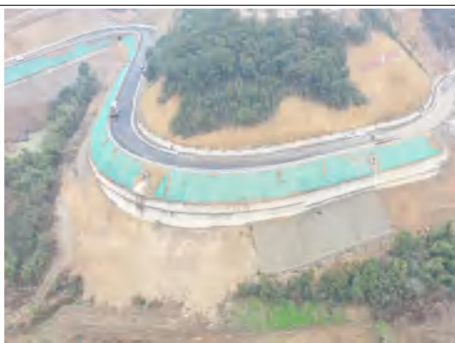
道路填筑边坡临时苫盖防护
