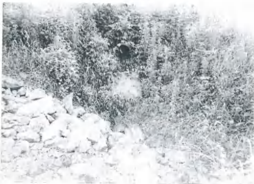
出水管封堵前
