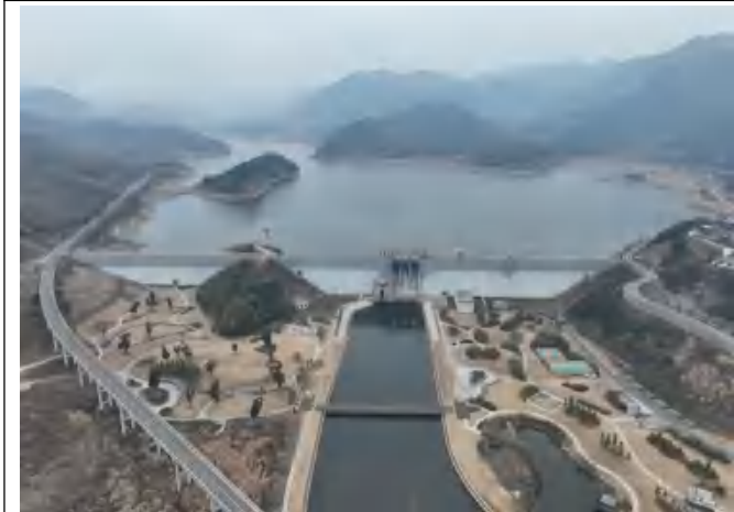
水库工程现状面貌
