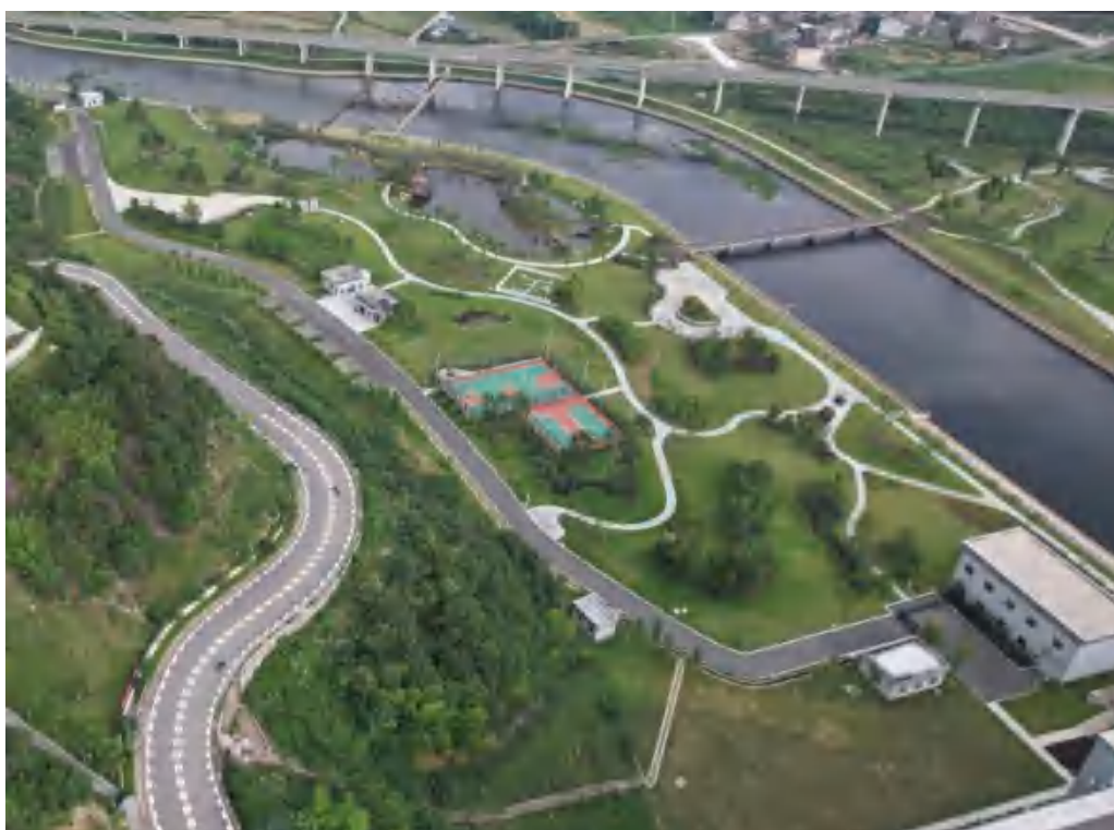
坝下管理区现状面貌
