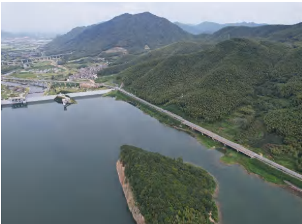
库区公路（A 线）现状面貌
