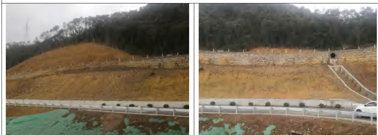
库区公路开挖填筑边坡覆土
