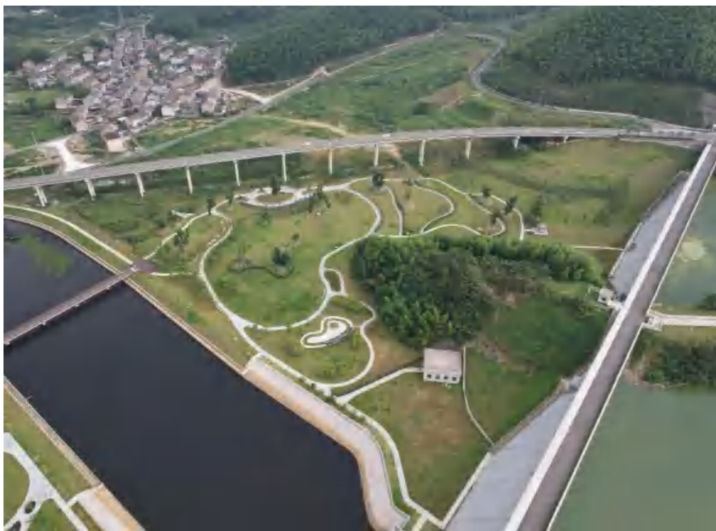
坝下管理区现状面貌
