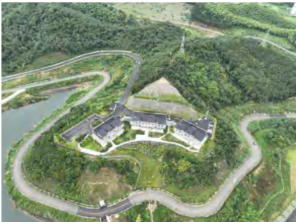
水库管理房及进场道路现状面貌
