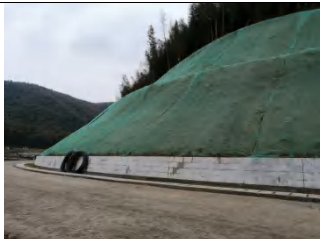
道路开挖边坡苫盖防护
