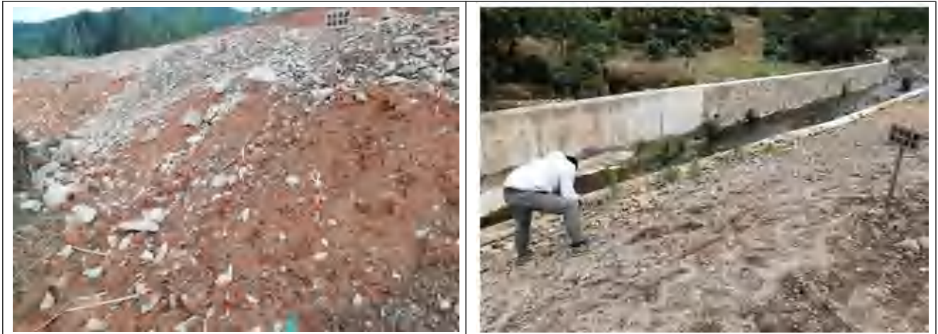
测钎法获取水土流失基础数据（库区公路工程开挖回填边坡）
