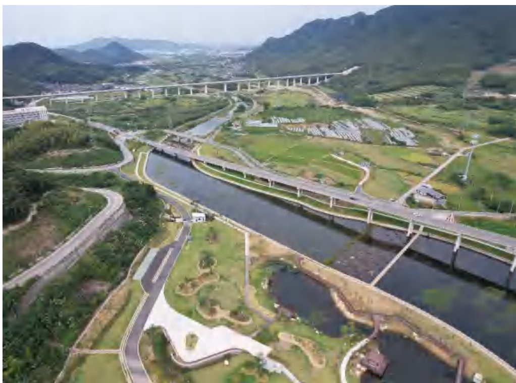
下游河道及两侧河岸现状面貌
