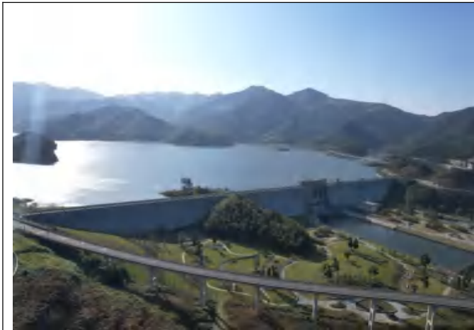
水库工程现状面貌
