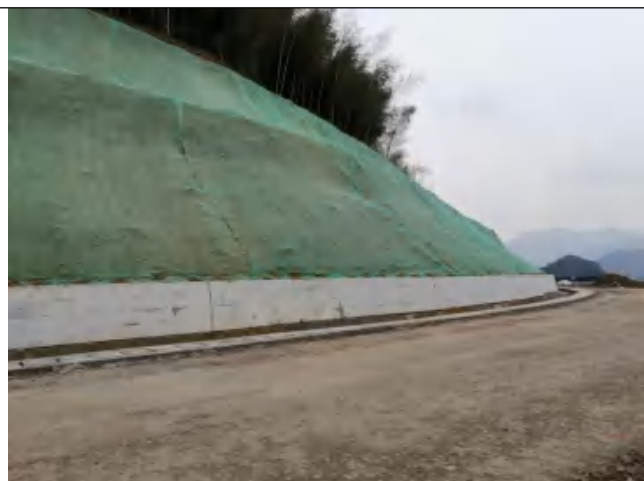
道路开挖边坡临时苫盖防护
