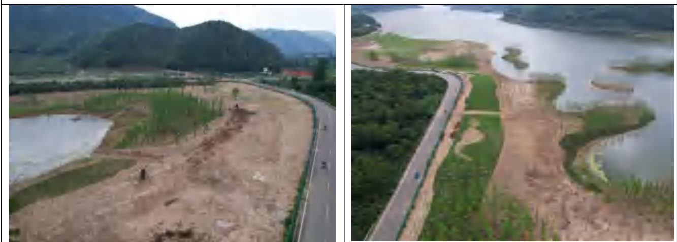
库尾消落带覆土
