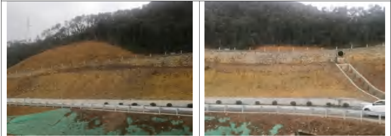
库区公路开挖填筑边坡覆土
