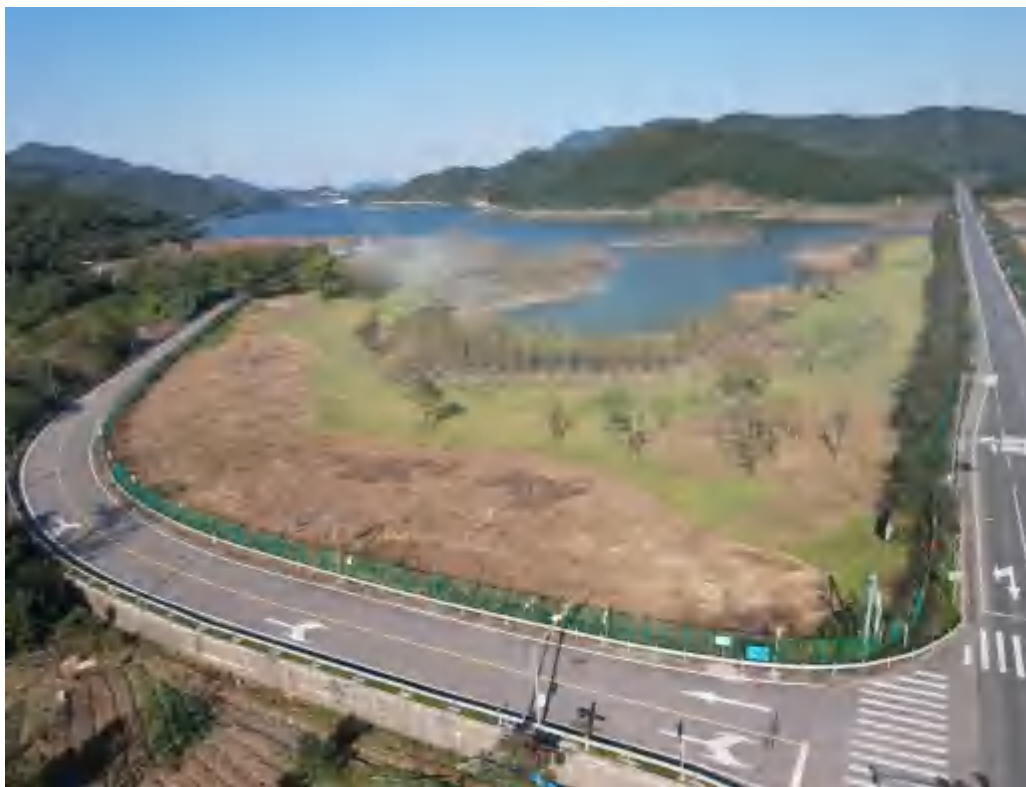
库尾消落带现状面貌
