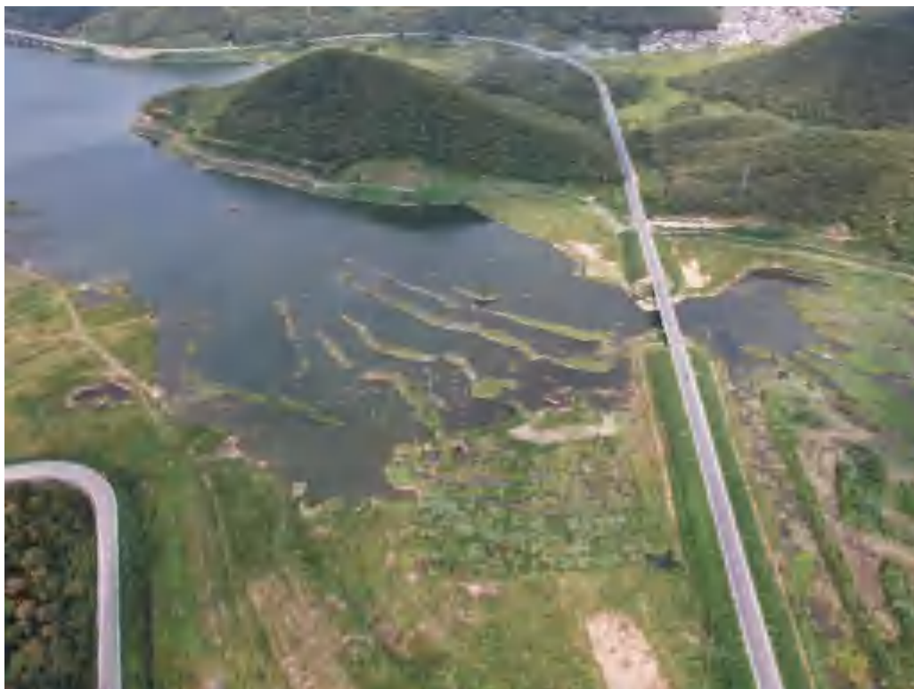
库区公路（A 线）现状面貌
