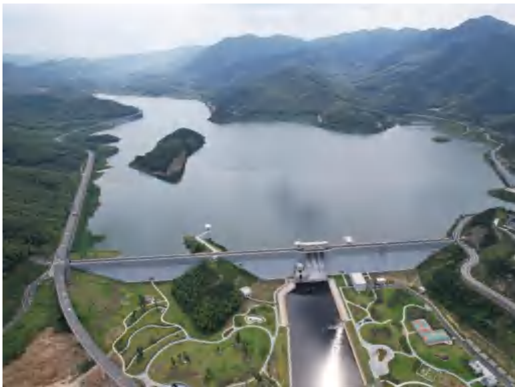
大坝主体及库区现状面貌
