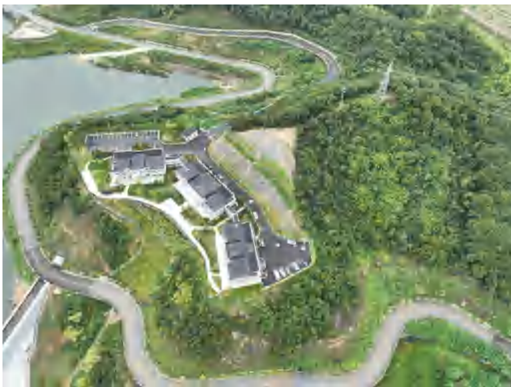
水库管理房及进场道路现状面貌
