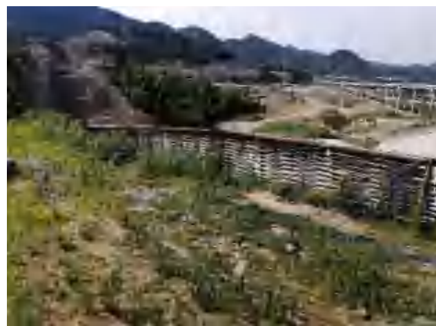
采取拦渣栅栏进行拦挡，避免顺坡溜渣
