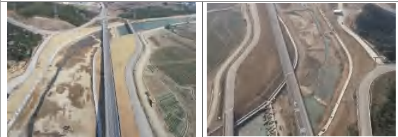
河道工程绿化覆土
