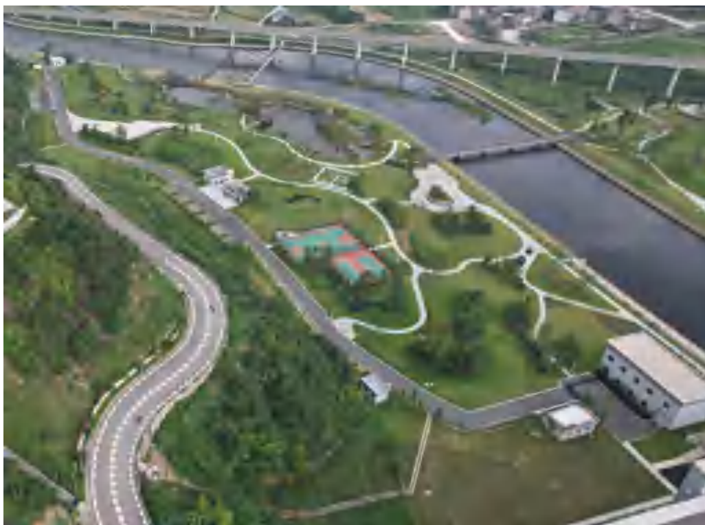
坝下管理区现状面貌
