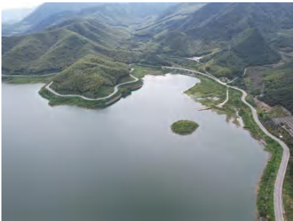
库区公路（B 线）现状面貌
