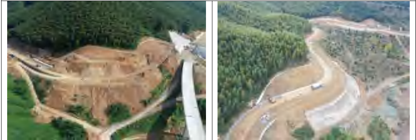
库区公路开挖填筑边坡覆土
