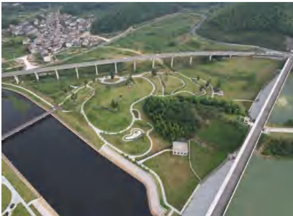
坝下管理区现状面貌
