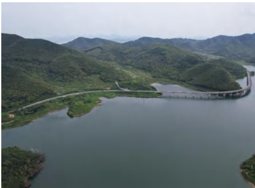
库区公路（A 线）现状面貌
