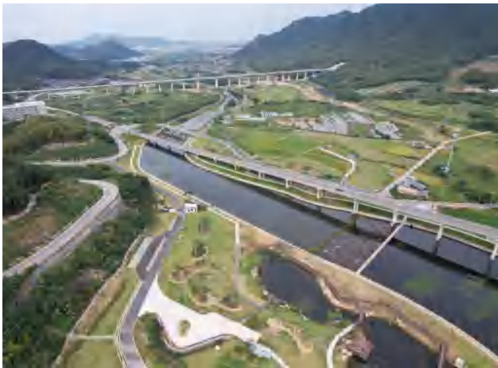
下游河道及两侧河岸现状面貌
