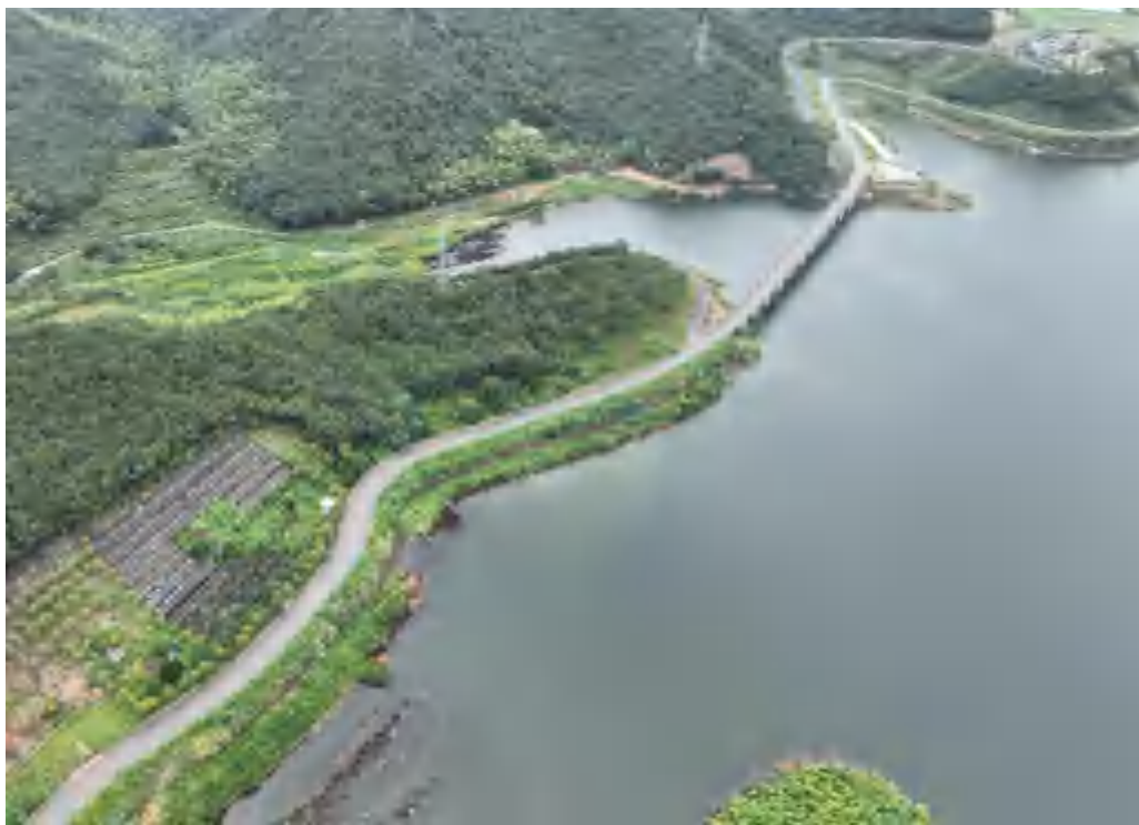
库区公路（B 线）现状面貌
