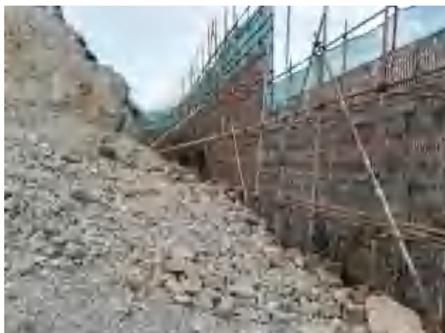
采取拦渣栅栏进行拦挡，避免顺坡溜渣
