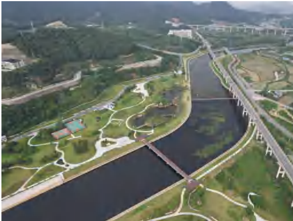
下游河道及两侧河岸现状面貌
