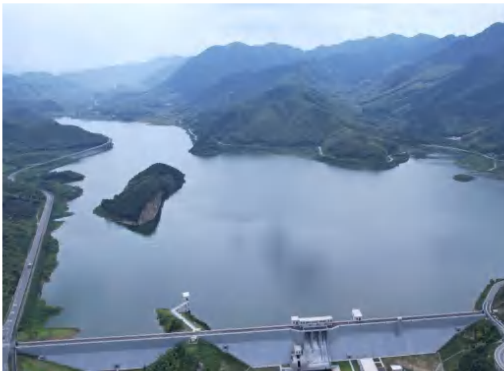
水库淹没区现状面貌
