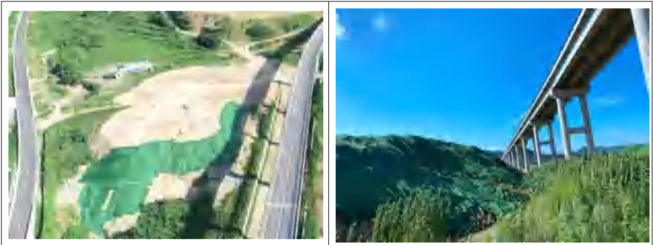
坝前 1#、2#表土堆场临时苫盖防护
