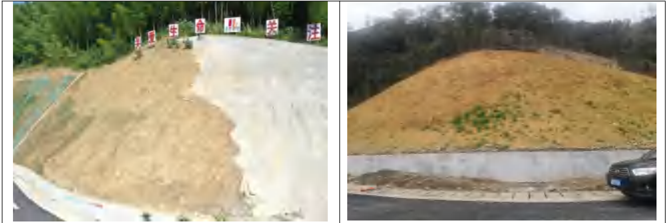
库区公路边坡绿化喷播覆土
