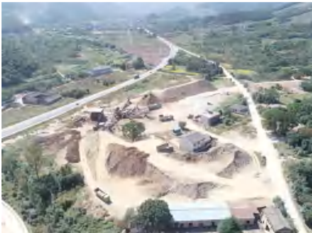
库尾砂石料筛分加工站施工面貌
