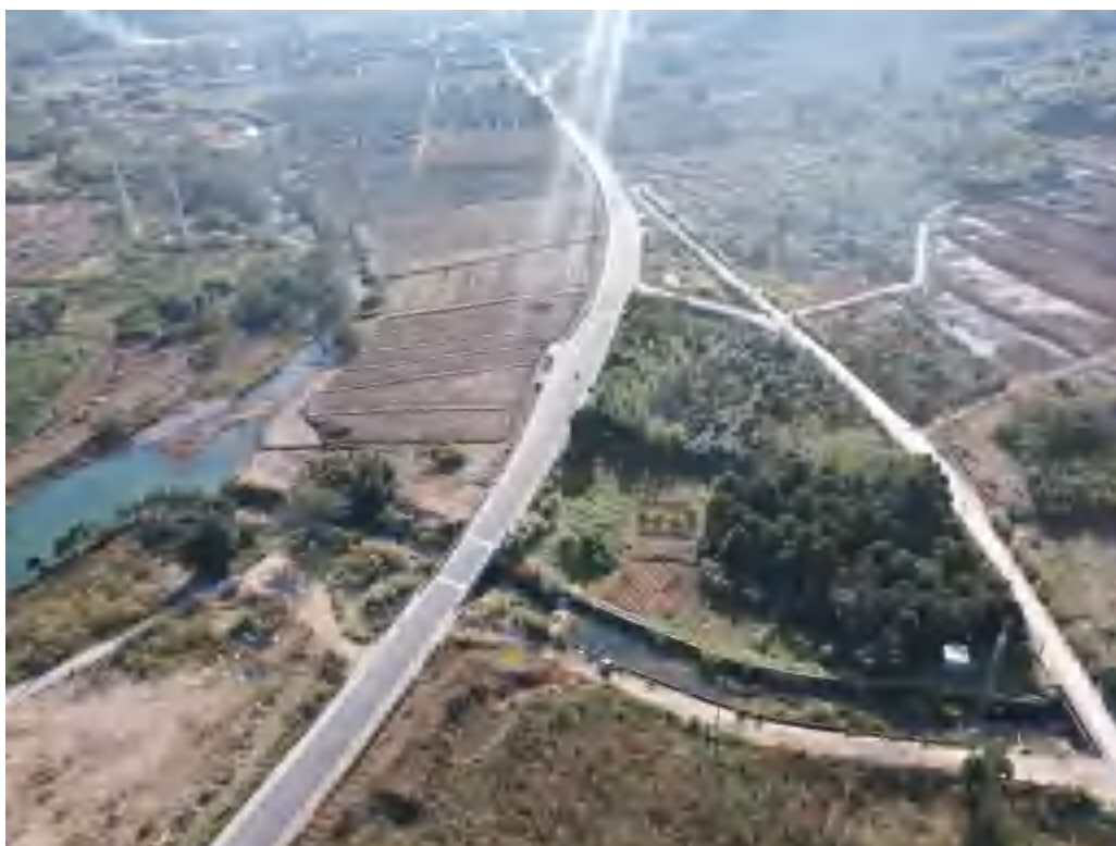
库区公路（A 线）现状面貌
