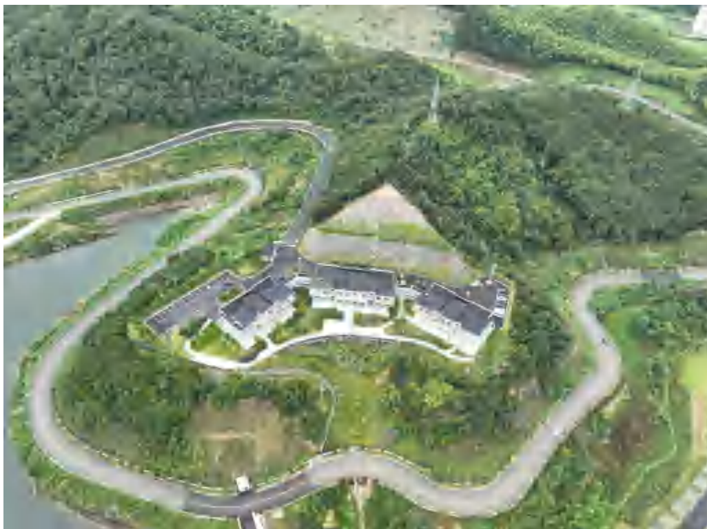
水库管理房及进场道路现状面貌
