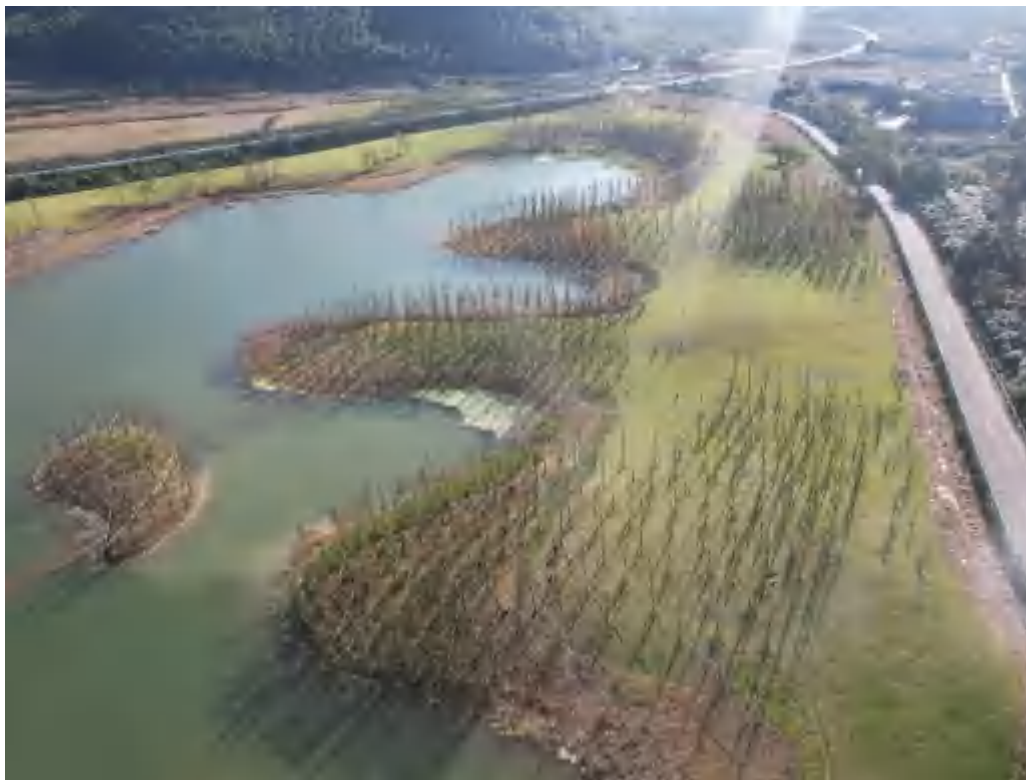
库尾消落带现状面貌
