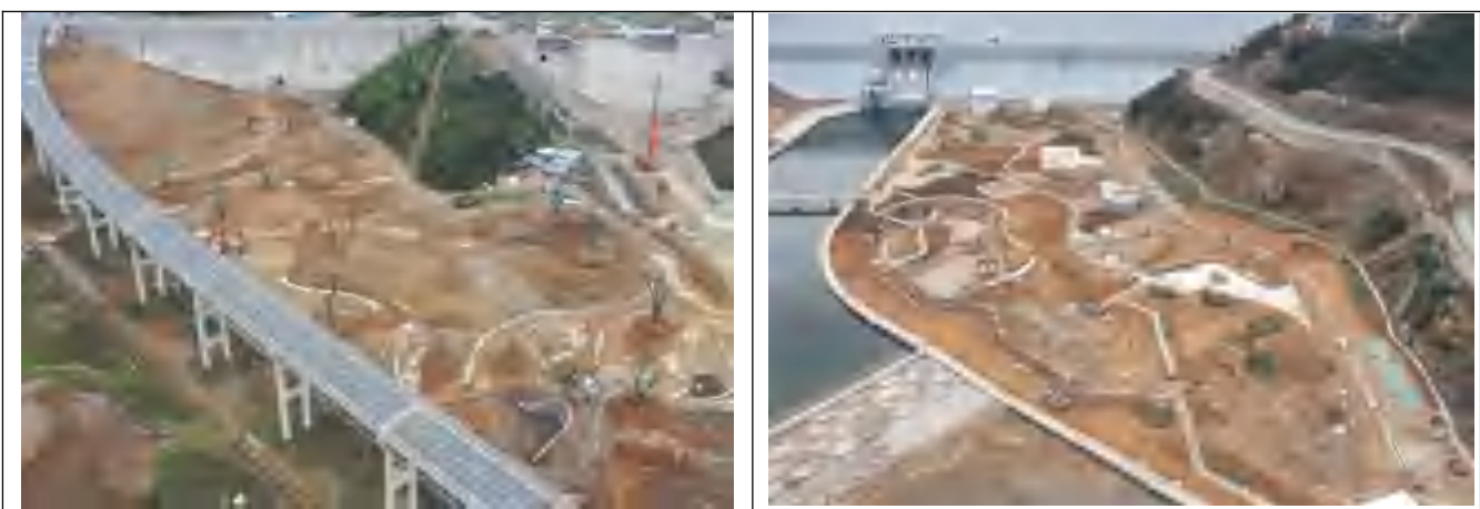
水库管理区绿化覆土
