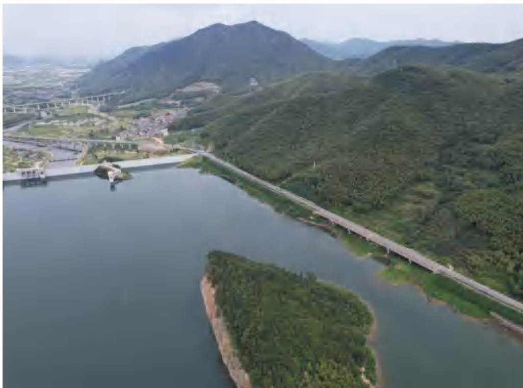
库区公路（A 线）现状面貌
