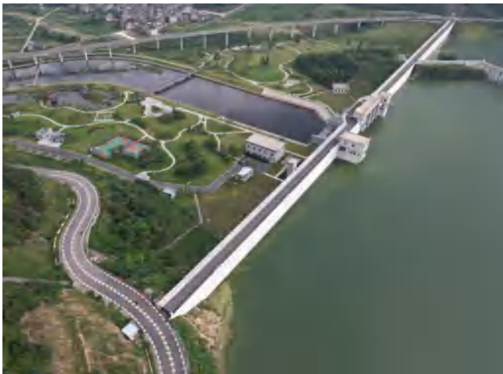
大坝主体现状面貌
